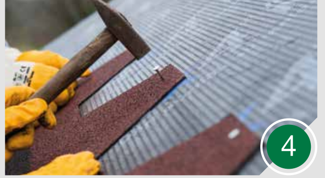
Shingle levhalarının teknik özelliklerine uygun olarak mekanik olarak tespit edilmesi
