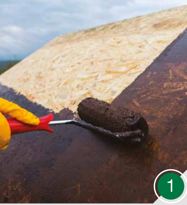
Yüzeylerin 4x4 bitümlü solüsyon ile astarlanması
