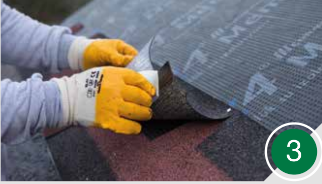
İşaretleme yapılan yüzeye saçaklardan başlayarak shingle uygulaması
