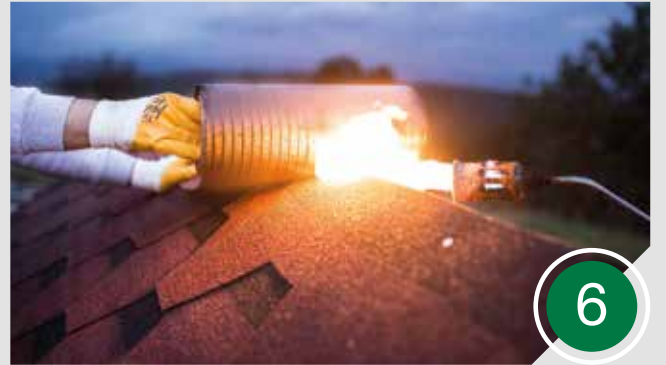
Malzemenin aslına uygun 4x4 Mahya Bantları ile çatı sırtının kaplanması
