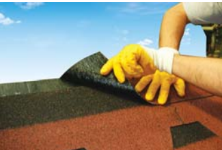
4. Coller sur la surface d'application et exercer une pression
