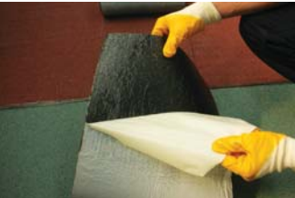
3. enlever le film protecteur sous la surface inférieure
