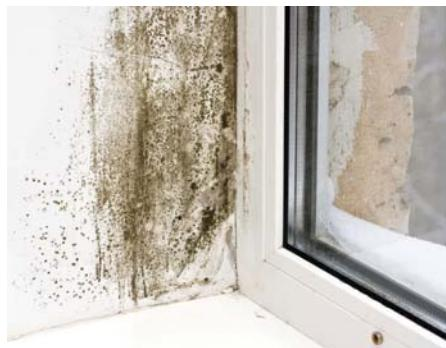
В таких условиях воздух находится в неопределенном состоянии, что предполагает выхода некоторого количества пара в качестве конденсата при незначительном снижении температуры.
