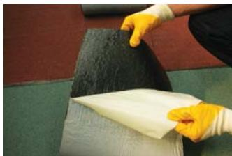
3. Снимите предохранительную плёнку на изнаночной стороне.
