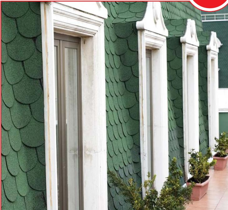
• Модифицированный пластомер – это битумное влагозащитное покрытие на основе стекловолокна, имеющее на лицевой стороне покрытие минеральным материалом, а на изнаночной покрытие песком.
